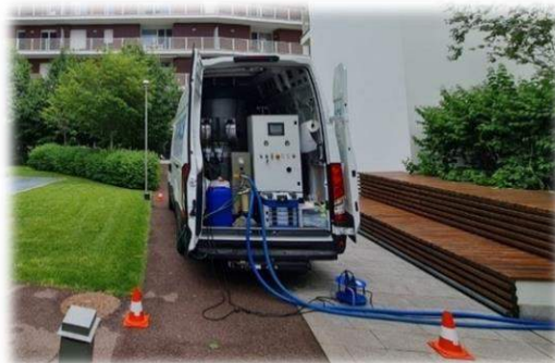
Figura 3: Esempio esecuzione intervento Legionellosi
