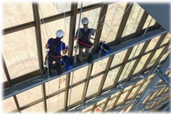
Figura 1: Esempio svolgimento Pulizia e manutenzione in quota su fune
