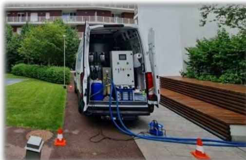
Figura 3: Esempio esecuzione intervento Legionellosi
